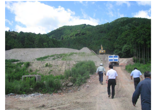
処分場確認調査
