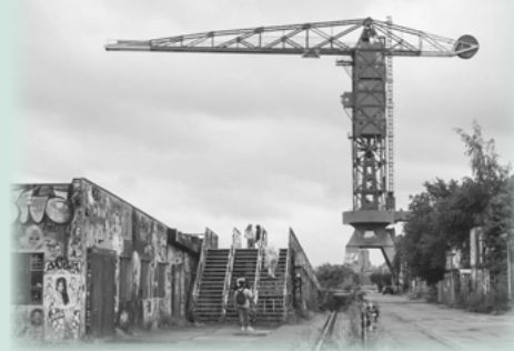
アムステルダム市にある旧造船所のクレーンをリノベーションしたホテル
