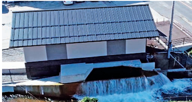
写真 小布施松川小水力発電所
