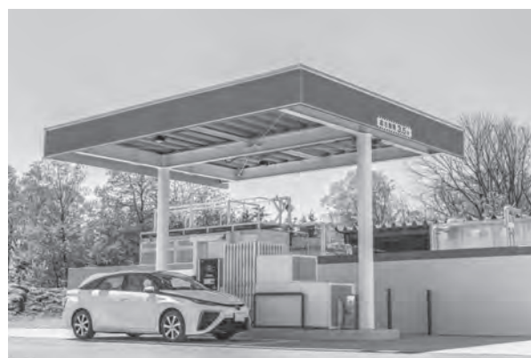
写真 水素ステーション
