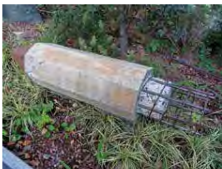
写真2 コンクリート杭先端部
