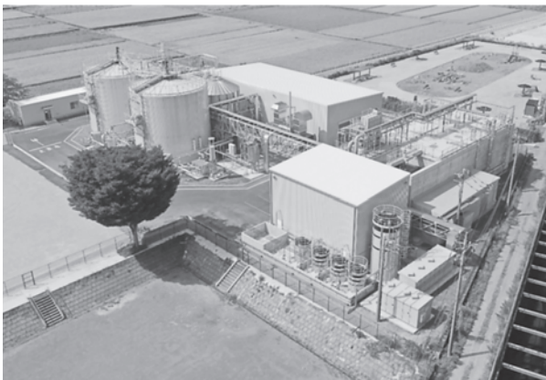
写真1 プラント全体
