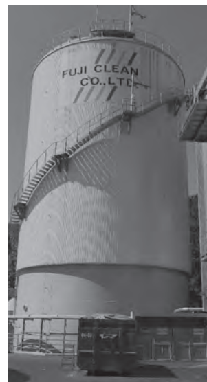
写真2 縦型乾式メタン発酵施設
