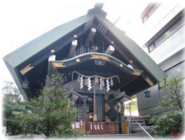
写真1 築土神社社殿(平成6年建替え)
