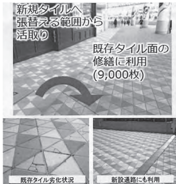
写真5 既存タイル面の修繕に再利用されたタイル
