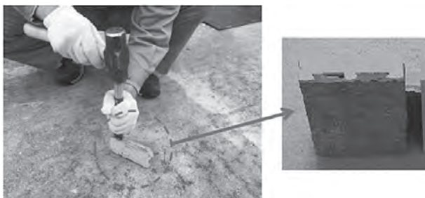
写真1 タイルの裏まで付着したモルタルの手作業による除去
