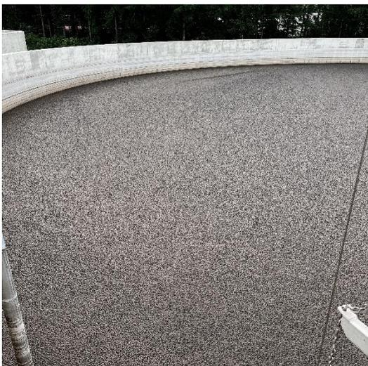
家畜ふん尿をメタン発酵した後の発酵残さを固液分離したもの（液肥）を貯めた貯留槽
