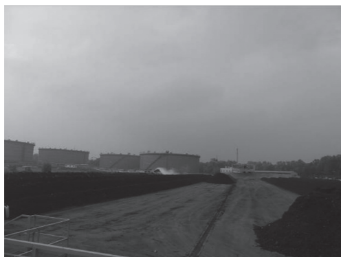
写真3 オープンコンポスト化施設
