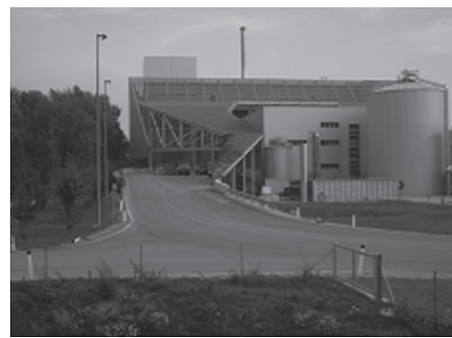
写真4 高効率廃棄物発電施設とバイオガス化施設
