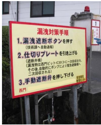
写真2 漏洩対策手順看板
